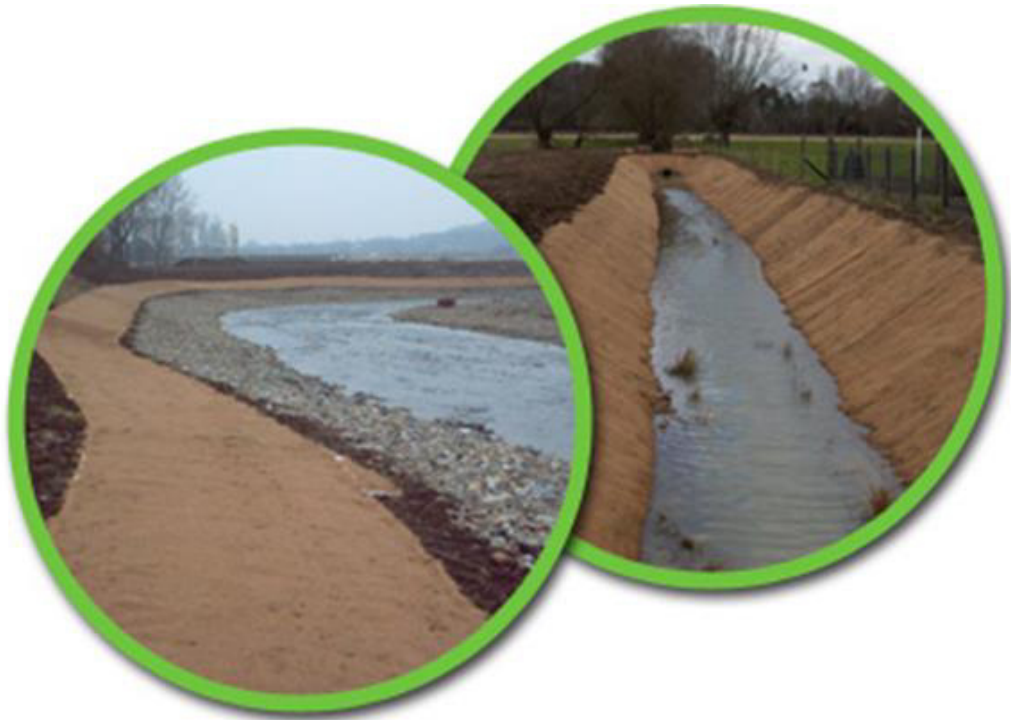
Abbildung 14: Erosionsschutz- bzw. Saatmatten (Bild: BGS Ingenieurbiologie und Vegetationstechnik).
